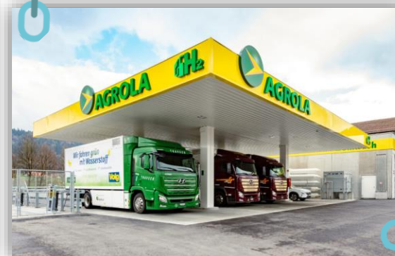
Stazione rifornimento a 350/700bar
