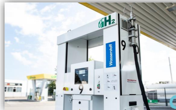
Stazione rifornimento a 350/700bar
